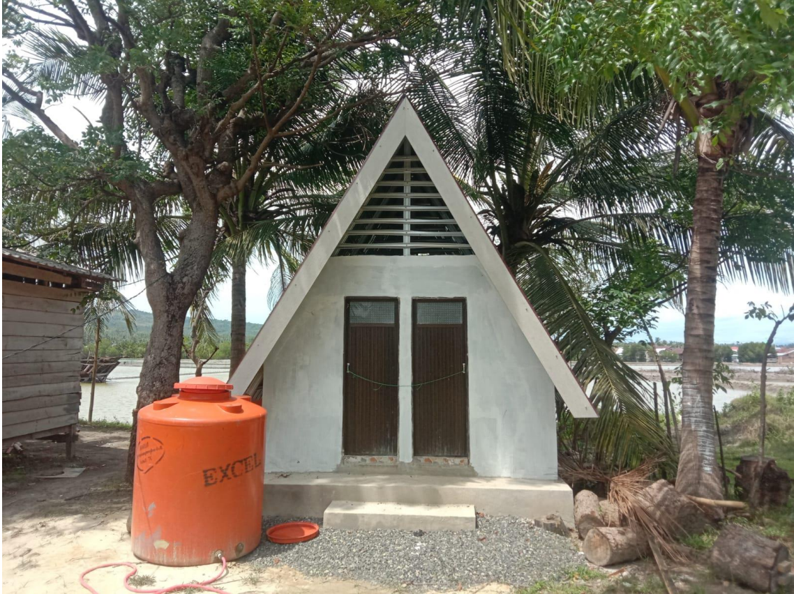
Gambar 7 : Pembangunan Toilet di Kec.Campalagian
