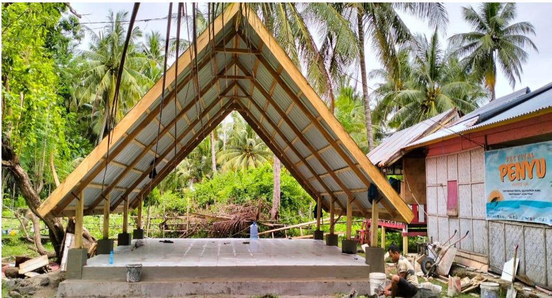
Gambar 8 : Pembangunan Ruang Serba Guna di Galeso
